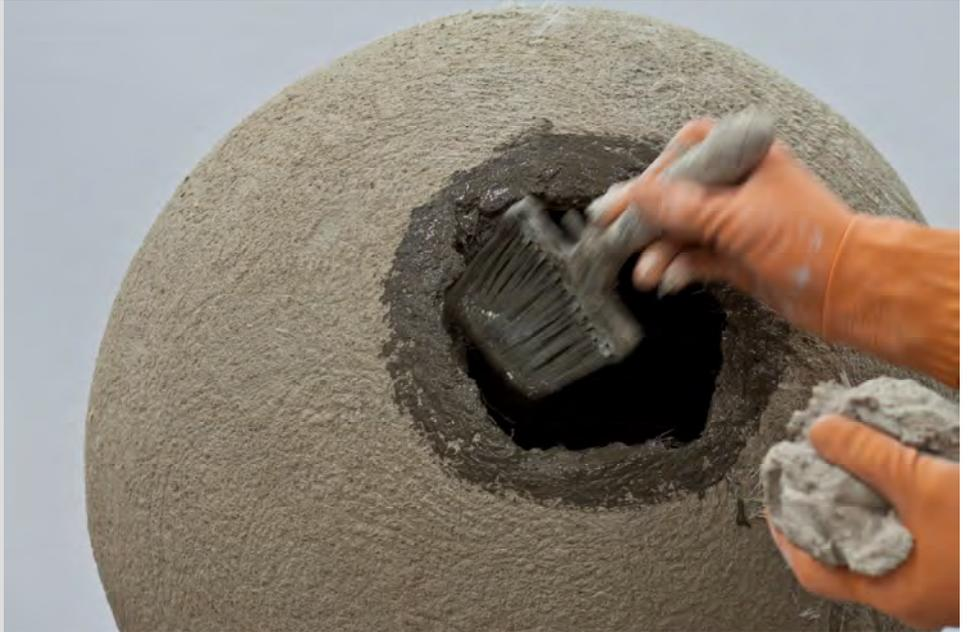
Bild links: Für das so genannte Angarnieren von Mörtel an den Rand der Kugelöffnung braucht man einen etwas steiferen Mörtel. Dazu nimmt man einfach etwas weniger Anmachwasser.
