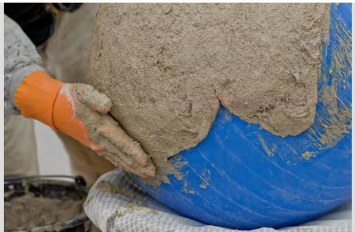
Betoniert wird im ersten Gang nur bis etwa zum Äquator. Am Rand streicht man den Mörtel dünn aus, damit keine harte Kante entsteht.
