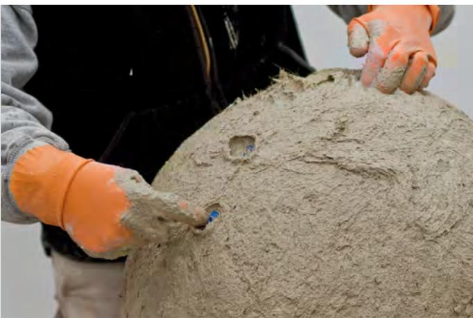
*Gelegentliche Probebohrungen mit dem Finger zeigen, ob die Schichtdicke ausreichend ist. Der frische Mörtel soll überall etwa 1 cm dick aufgetragen werden.*
