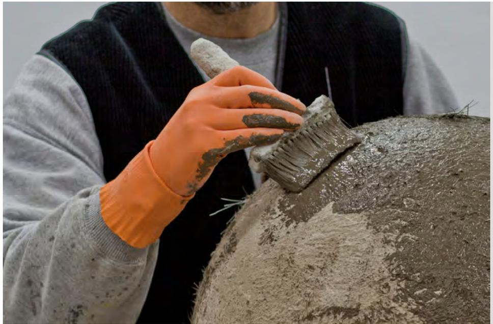
*Die Zementschlämme stellt die Verbindung zwischen der ersten und der zweiten Mörtelschicht her. Das tut sie, indem sie in alle Ritzten des rauhen Untergrunds läuft, um sich dort nach ihrer Erhärtung dauerhaft zu verkralen. Es reicht aus, die Schlämme nur dünn aufzutragen, allerdings muss die Oberfläche gründlich und lückenlos benetzt sein. Wo sich Pfützen bilden, werden Sie mit dem Pinsel weggestrichen, denn wir wollen nicht, dass uns die nun folgende Mörtelschicht darauf wegrutscht.*
