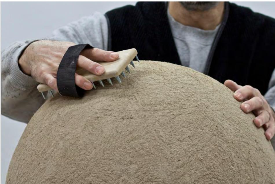
Mit dem Beschleifen der zweiten Mörtelschicht bekommt die Kugel ihre endgültige Gestalt. Wer hier besondere Sorgfalt und Ausdauer an den Tag legt, kann es mit Hilfe des Edelputzkratzers zu einer Form von beachtlichem Ebenmaß bringen. Wer es lieber rustikal mag, spart Arbeit. Um auch noch die im Folgenden beschriebene Oberflächenbehandlung vornehmen zu können, muss aber in jedem Fall die Oberfläche aufgeraut werden, damit der nachfolgende Feinschichtmörtel Halt findet.
