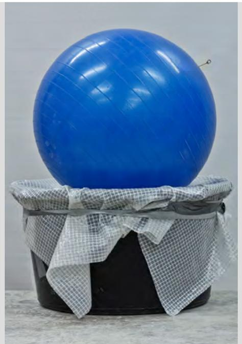
Darin liegt der Gymnastikball sicher ohne wegzurollen, und die entstehende Betonkugel wird beim Bau ideal gestützt.
