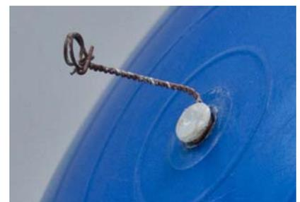
*Eine Markierung am Ballventil kann sehr hilfreich sein, wenn das Ventil einmal versehentlich einbetoniert wurde. Dann findet man es nämlich durch den Beton hindurch trotzdem wieder. Hier ist es einfach eine Drahtöse, die um den Kopf des Ventilstößels geschlungen und dann verdrillt wurde.*
