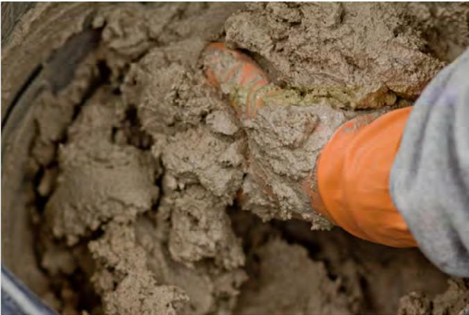
Der Mörtel wird zunächst ohne Glasfasern kräftig durchgearbeitet. Erst wenn eine durch und durch homogene, weiche Masse entstanden ist, kommen die Fasern hinzu und werden gründlich untergemischt.
