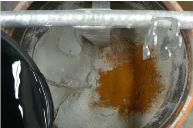
Bei stehender Mischtrommel wird befüllt. Im Zwangsmischer muss immer erst die Trockenmasse und dann das Wasser eingefüllt werden. Im Bild sieht man auch noch oranges Pigment.
