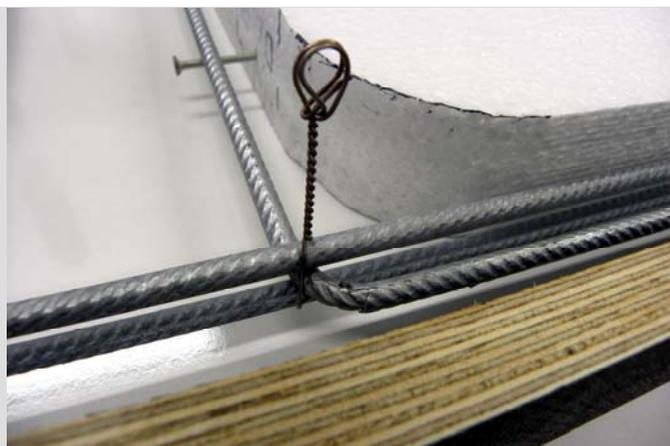
Rings um die Herdaussparung und besonders in den bruchgefährdeten Bereichen neben der Aussparung ist eine Bewehrung aus Moniereisen oder Fiberglasstäben erforderlich.
