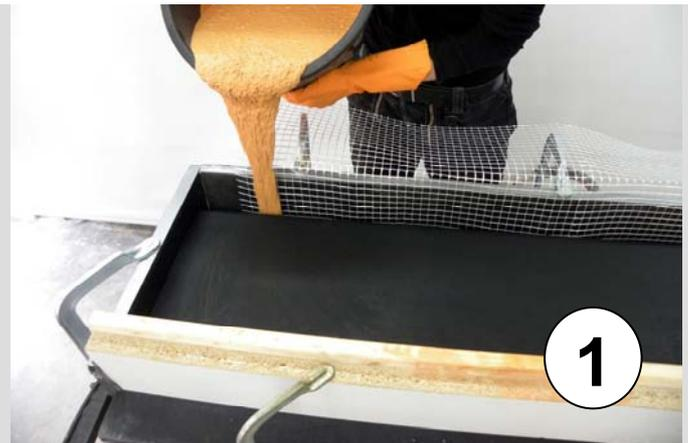
Die Bewehrung für die Aufkantung wird in den vorgesehenen Spalt gestellt und der Beton so eingegossen, dass er das Bewehrungsgitter an die Rückwand drückt, wo es nicht stört.
