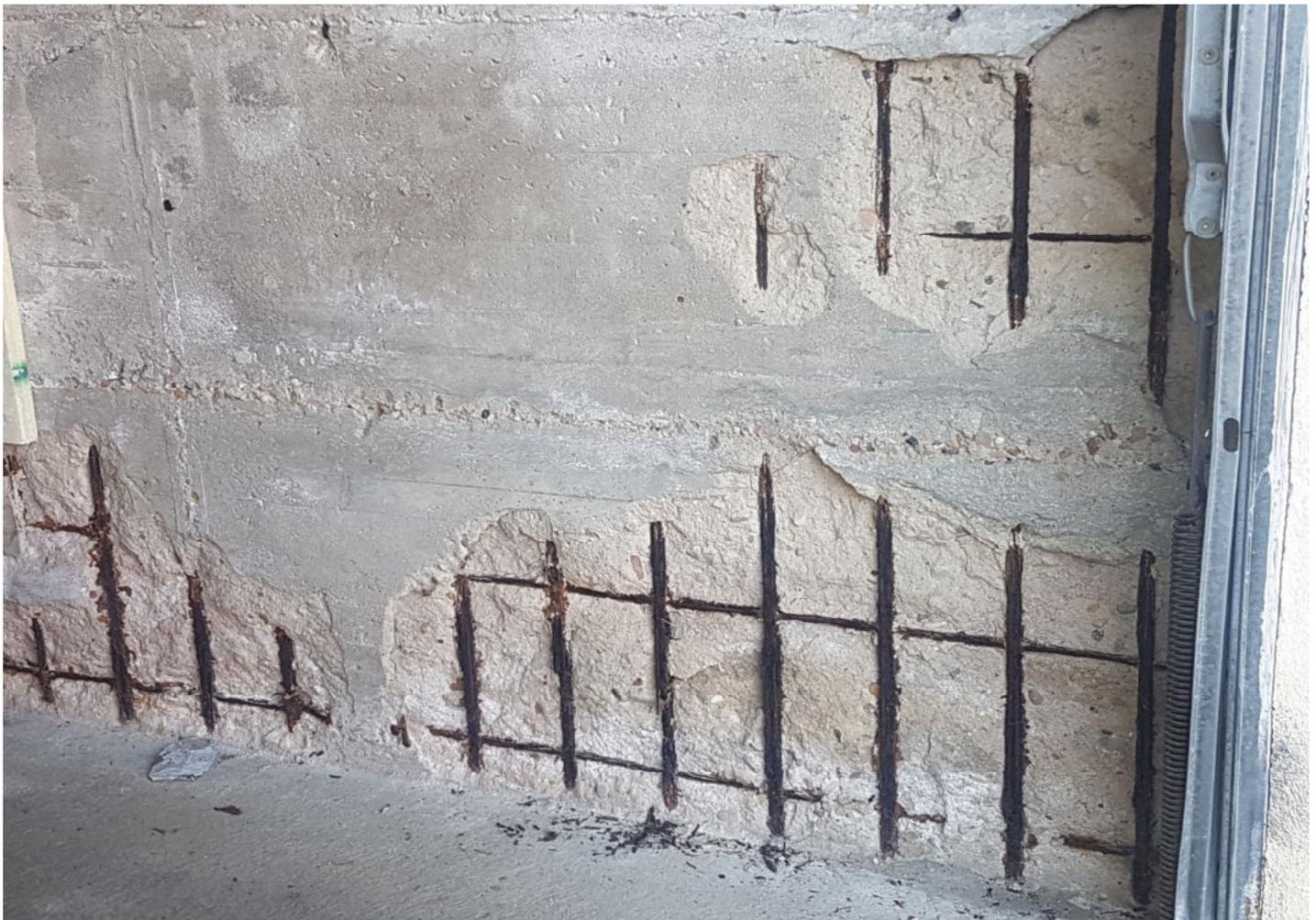
Bei dieser Wand ist die Betonüberdeckung zu gering. Dadurch konnte die Stahlbewehrung rosten und die Deckschicht absprengen.
