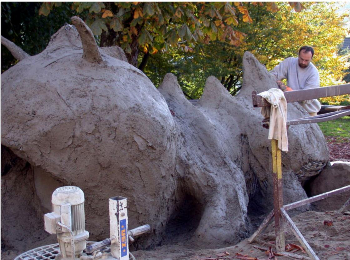
*Bei großen Objekten ist zuerst einiger Aufwand für den Bau der Unterkonstruktion erforderlich. In diesem Bild besteht sie aus Rippenstreckmetall, das mit darüber gelegten Moniereisen verstärkt ist. Die Fixierschicht, die hier gerade aufgetragen wird, lässt stellenweise noch Metallteile hervorspringen, die später unter weiteren Betonschichten verschwinden. Für diese Arbeit eignet sich der Grundmörtel GRUMO.*
