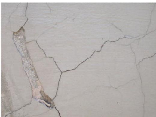
*Schwindrisse entstehen durch Spannungen aus dem Abbindevorgang. Im hier abgebildeten Fall lag der Fehler darin, dass die harte Deckschicht auf einen zu weichen Untergrund aufgetragen wurde. Anstatt die Spannungen aus der abbindenden Deckschicht aufzunehmen, gab der weiche Untergrund nach. Als Folge riss die Deckschicht auf und löste sich ab.*
