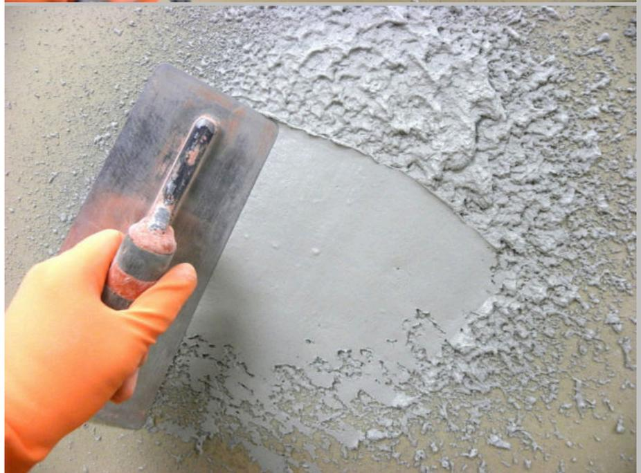
*Die Trichterspritzpistole ist sehr nützlich, um den Mörtel leicht und schnell auf größere Flächen aufzutragen. Das enthaltene Stellmittel gibt der Masse genau die benötigte Konsistenz und Standfestigkeit. Das Glätten erfolgt in der am Bau üblichen Weise mit der Glättkelle.*
