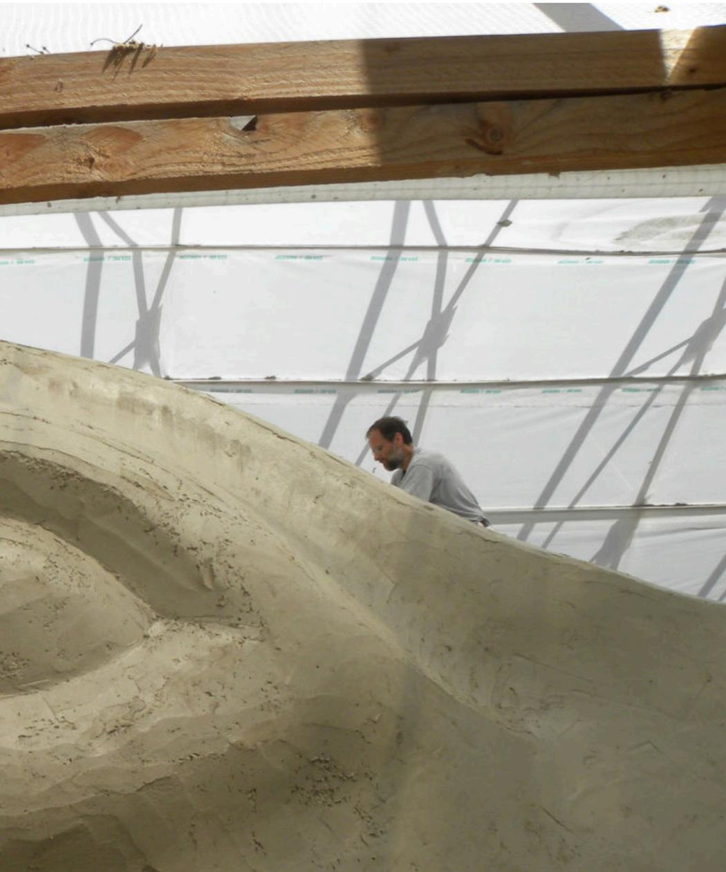
massiven. So entstehen dünnwandige und deshalb leichte, schalenförmige Objekte. Im Moertelshop gibt es speziell für die Laminieretechnik den LAMBO Laminierbeton, der dem Knetbeton sehr ähnlich, allerdings nicht knetbar sondern streichfähig eingestellt ist.
