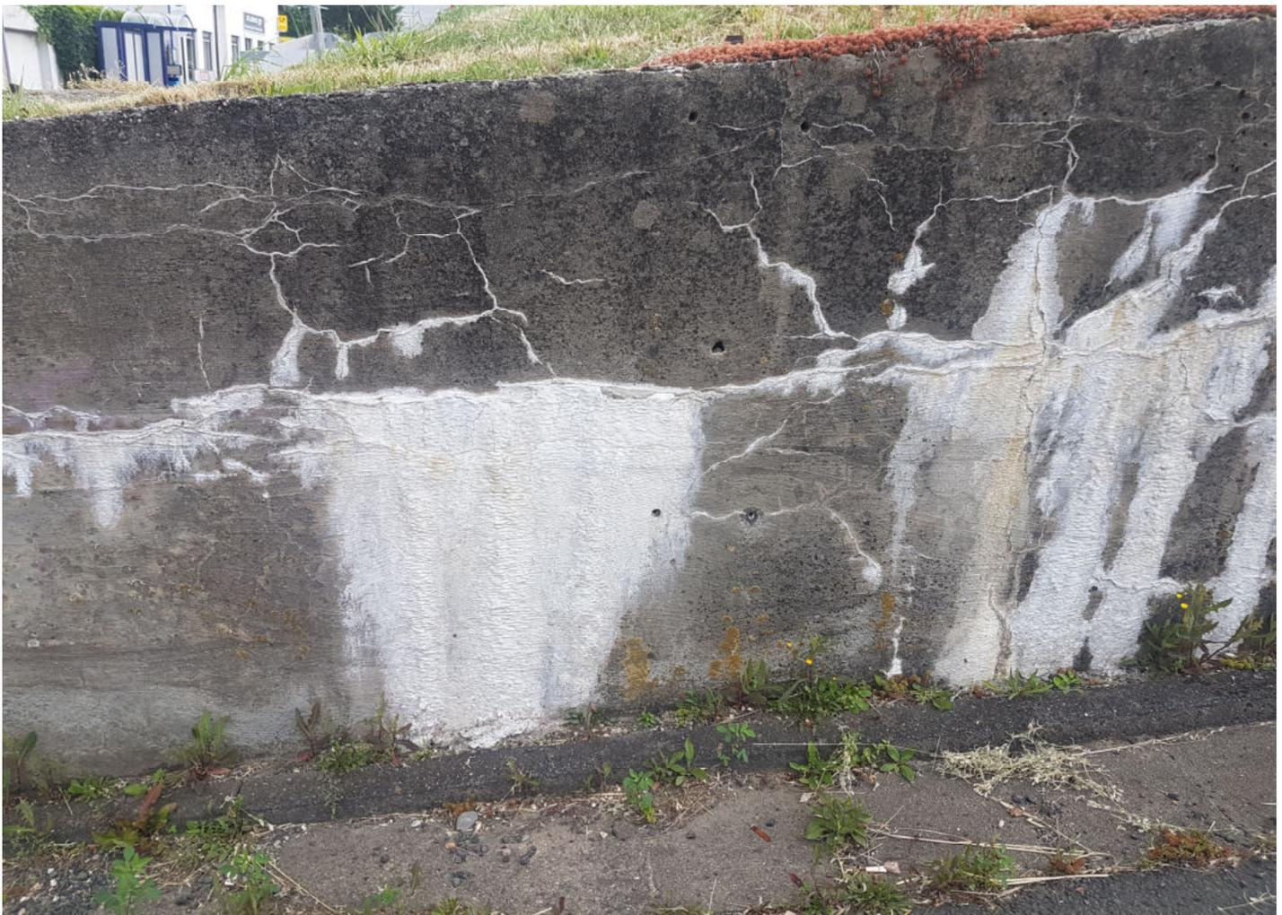
Diese Stützmauer ist dauerhafter Erdfeuchte ausgesetzt. Austretendes Wasser hat hier zu weißen Ausblühungen geführt.
