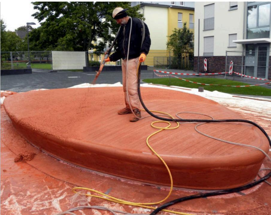
Wenn eine Putzmaschine zur Verfügung steht, kann sie das Betonieren großer Objekte sehr erleichtern. Für dieses Sitzpodest wurde rot eingefärbter GRUMO in mehreren Schichten aufgespritzt und mit schichtweise eingelegtem Glasfasergewebe bewehrt.
